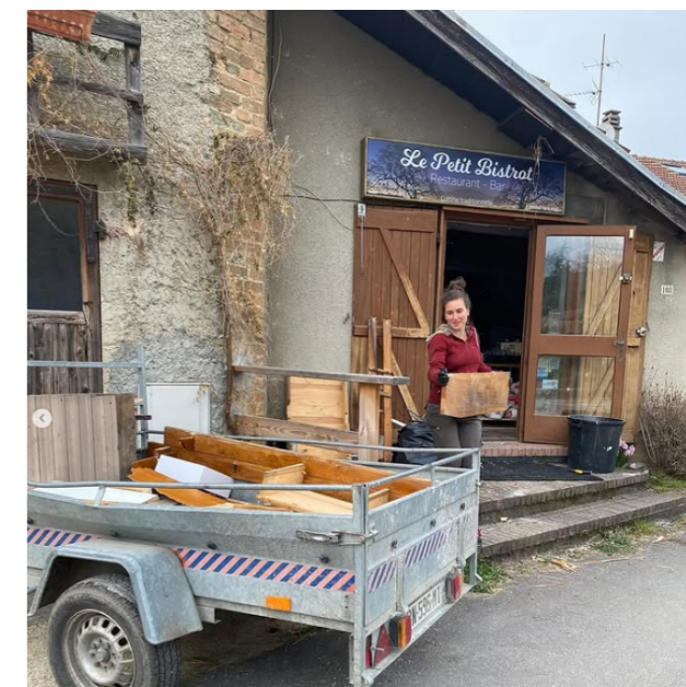
Travaux au Petit Bistro, Venon, Isère
