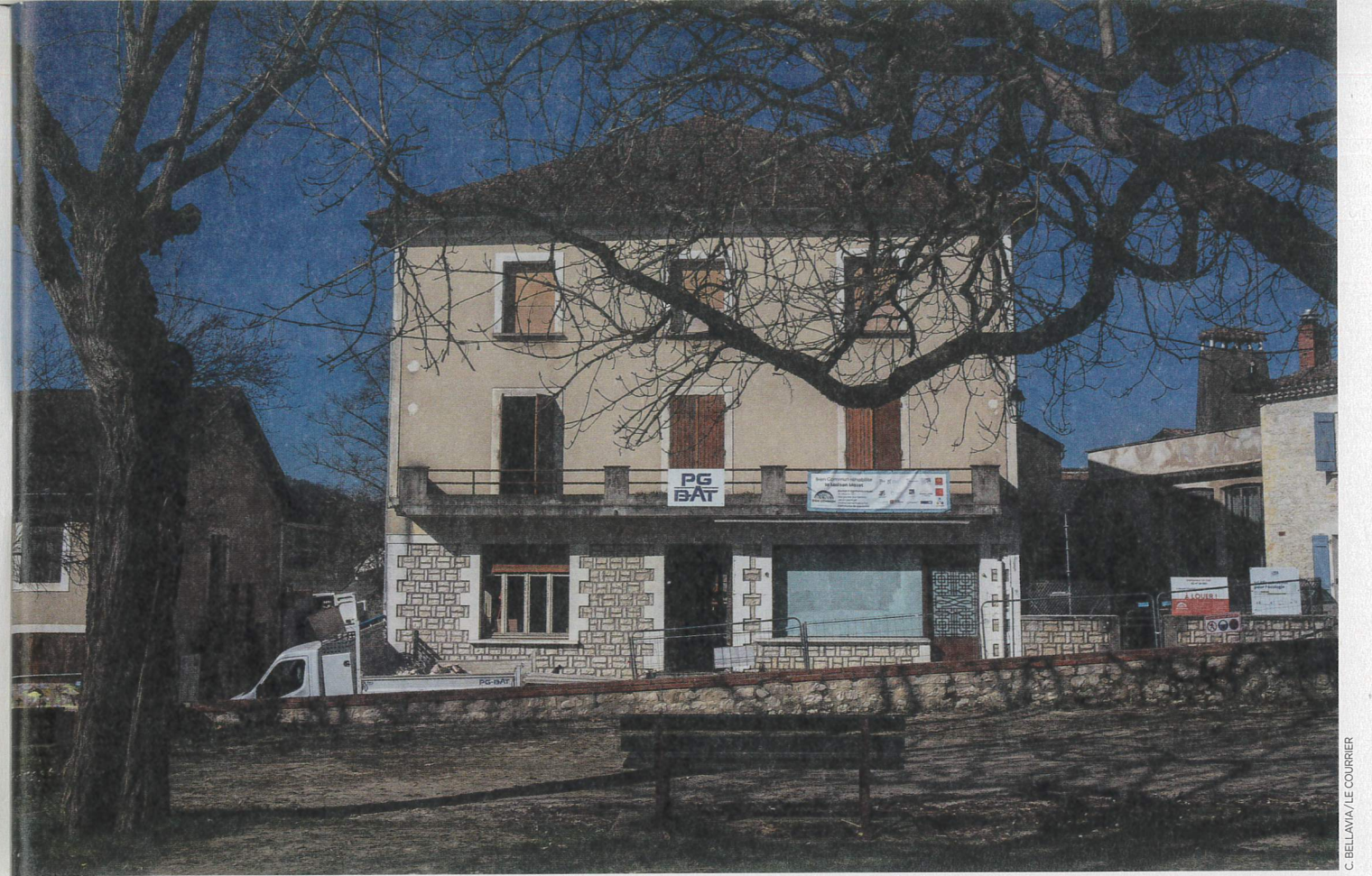
A Cazes-Mondenard (82), la foncière solidaire Bien commun a financé, via des levées de fonds citoyens, la réhabilitation de la Maison Mazet pour y créer un pôle commercial et des logements sociaux.
